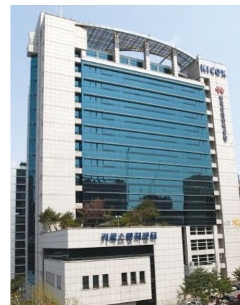
한국산업단지공단의 옛 본사인 구로동의 키콕벤처센터 건물이 민간업체에 팔렸다. 공기업 이전 절차에 따라 매각이 추진된 지 5년여만이다.
