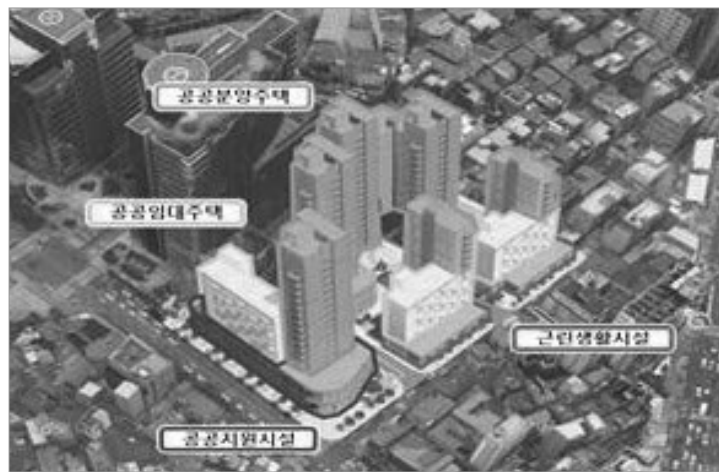
가리봉동 134-58 일대 1만3천604㎡가 정부가 추진하는 주거재생혁신지구 선도사업 후보지로 선정됐다. <사진은 개발조감도. 조감도는 관계기관 협의 등을 거쳐 변동될 수 있다.>
