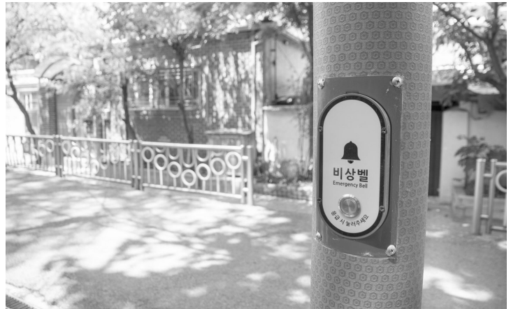
구로구가 안전한 생활환경 조성을 위해 노후 비상벨을 IP네트워크 인터넷전화 방식의 고성능 장비로 교체했다.
