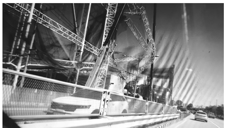
16일 저녁 7시쯤 구로구 일대에 초속 14m의 강풍이 불면서 골프장 철기둥이 무너졌다.골프장을 지탱하는 철기둥이 기역자로 꺾이면서 전깃줄 위로 쓰러져 고척동 일대 1,300여 가구에 정전이 발생했다. 전기 공급은 한 시간 반 만에 재개됐지만, 아파트 주민 10명이 승강기에 갇혔다가 구조되는 등 큰 불편을 겪었다. <채홍길 기자>
